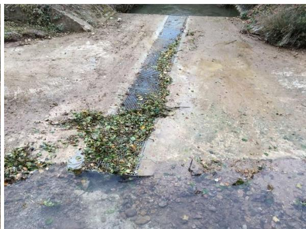
Figure 82 : Exemple de réalisation d'une échancrure au sein du passage à gué Douchy (source : IER, 2018)
