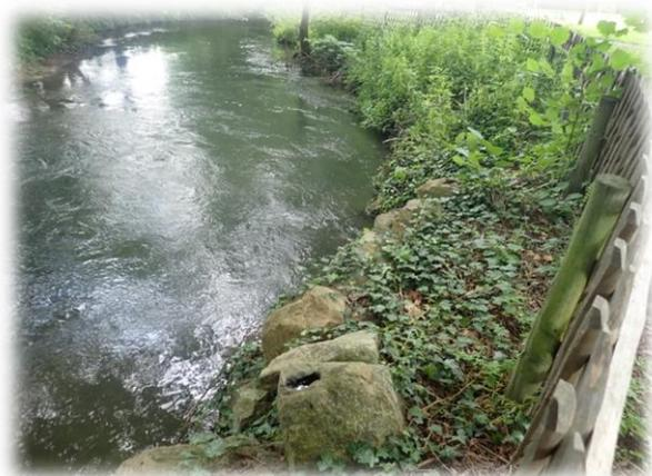
Figure 44 : Protection extrados en blocs
